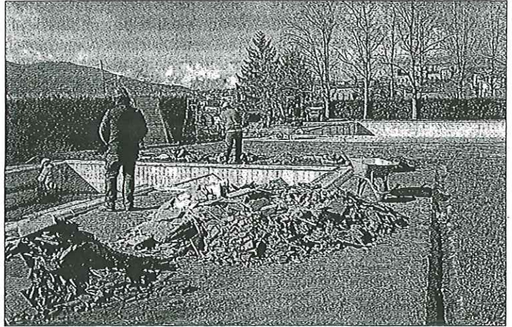
Operaris iniciant els treballs de reforma de la piscina municipal
