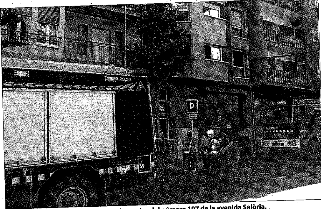
El fuego el calcinó el comedor del primer piso del número 107 de la avenida Salòria.
