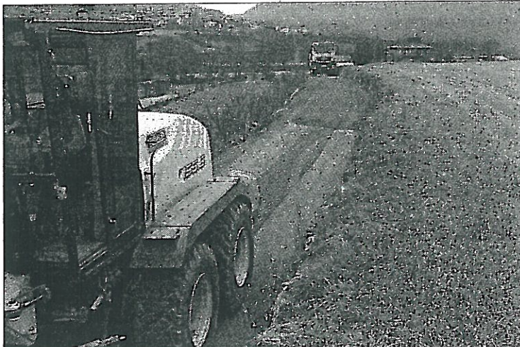
Els treballs per reparar el camí de les Bordes.
