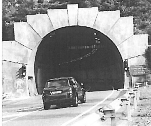
La boca sud del túnel del Cadí.
