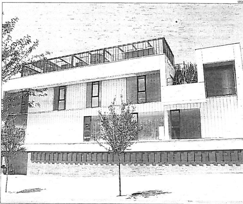
Imatge del CAP de la Mariola, una de les obres que es van acabar el 2009 i s'està pagant ara.
