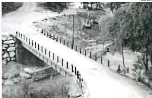
El pont d'accés a Arties s'ha hagut de reconstruir.
