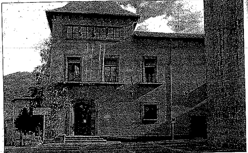
L'edifici de l'Ajuntament de la Seu d'Urgell, que ara serà escalfat amb biomassa local.
