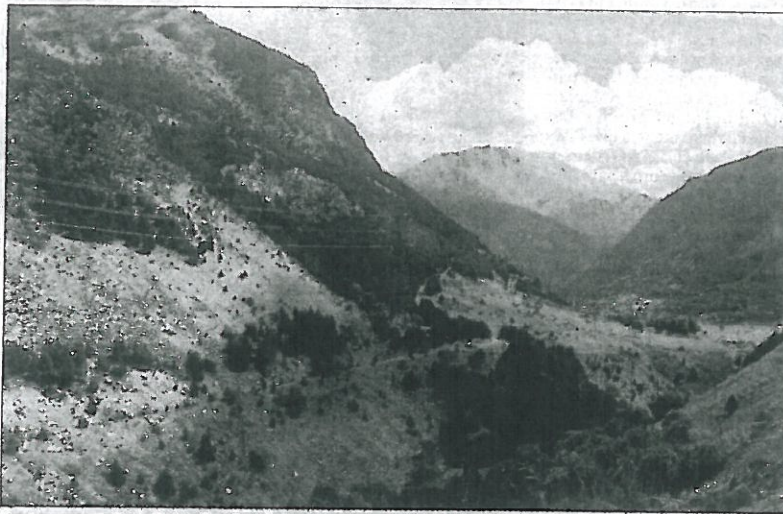
Imatge recent d'una línia elèctrica al municipi de la Torre de Capdella.
