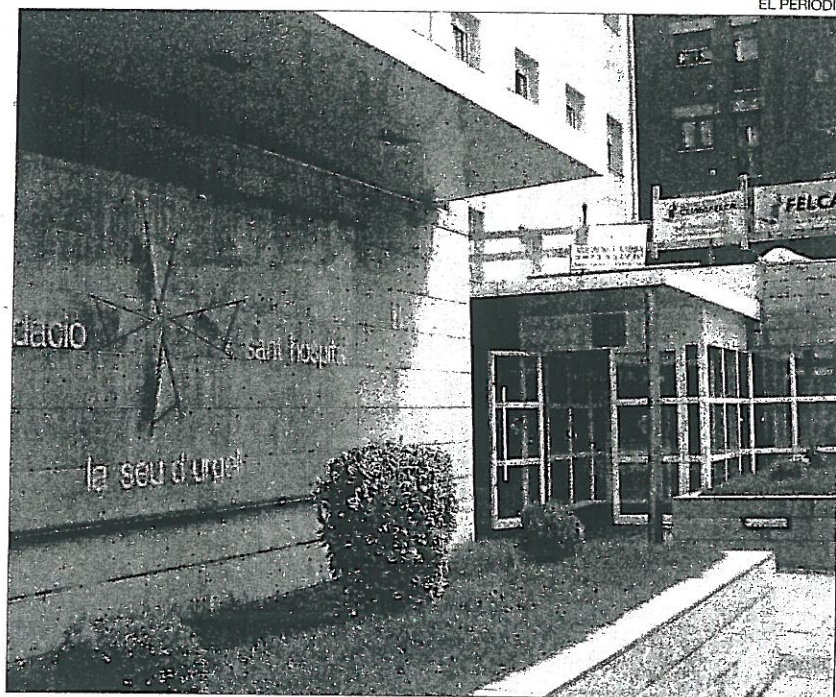
►► Façana principal de l'Hospital de la Seu al passeig Joan Brudieu.
