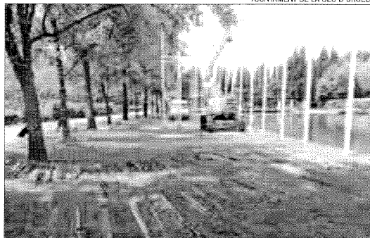
Un moment de la construcció del nou equipament al parc del Segre.
