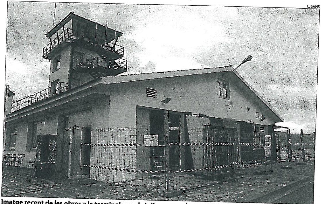
Imatge recent de les obres a la terminal per obrir l'aeroport de la Seu a vols comercials.
