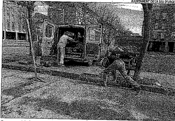
Reparació de voreres al carrer Comtat d'Urgell de la Seu.
