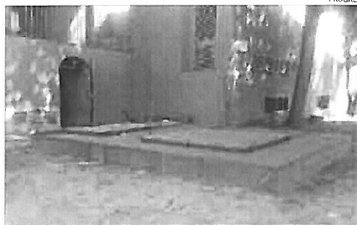
L'estructura de formigó per al dipòsit de biomassa al parc del Cadí de la Seu.
