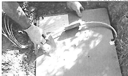
Un moment de la instal·lació d'un dels ecocomptadors de la xarxa.
