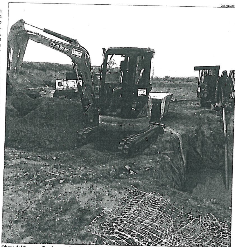
Obres del Segarra-Garrigues a Castellidans, un dels pocs municipis on s'han reprès.
