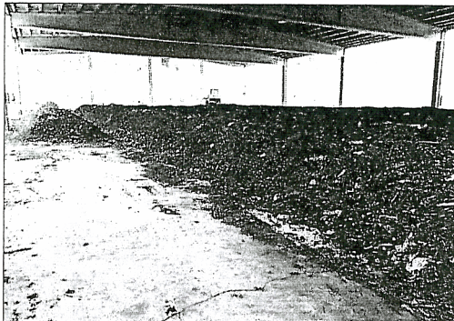
Imatge de la planta de compostatge de Benavarre.
