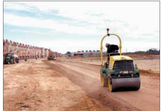
FOTO: Aj. Alpicat / Millora d'un solar a prop de l'avinguda del Parc
