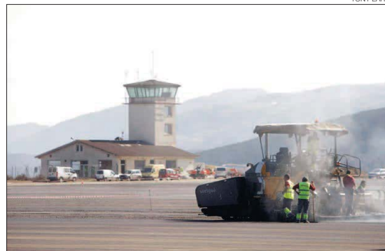
►► Obres de millora a la pista de l'aeroport de la Seu.
