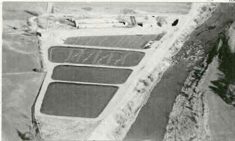
L'estació depuradora de Montferrer que gestiona el Consell Comarcal de l'Alt Urgell.
