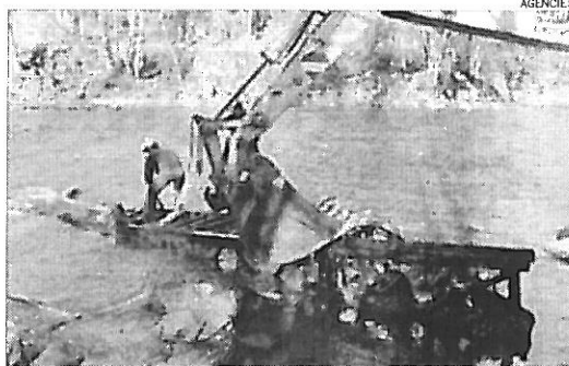
El braç d'una màquina excavadora retira restes d'un pont de ferro de mig del riu.
