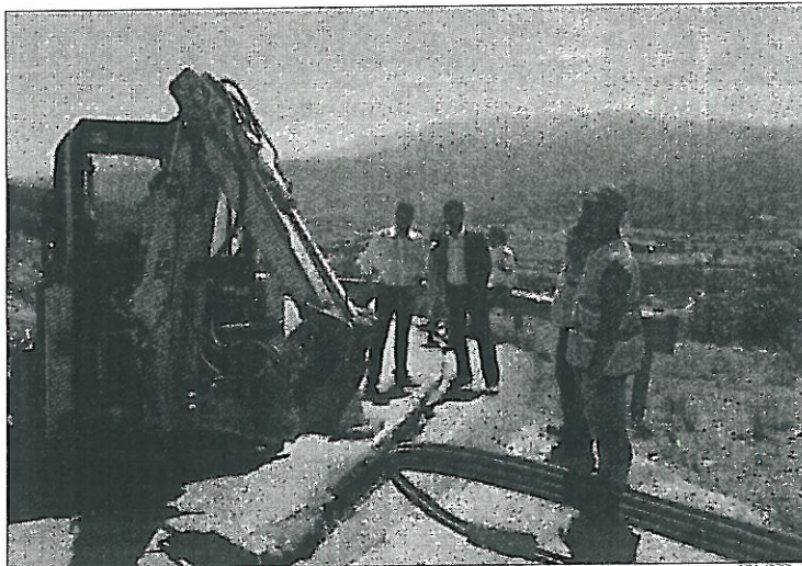
Obres per desplegar la fibra òptica a la Seu.
