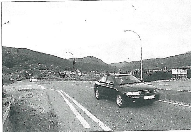
Imatge del punt on es construirà una de les gloriets.
