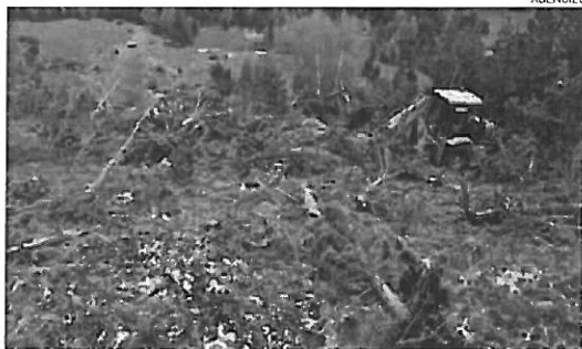
Una màquina obrint un camí ramader a la zona del pla de Boet.
