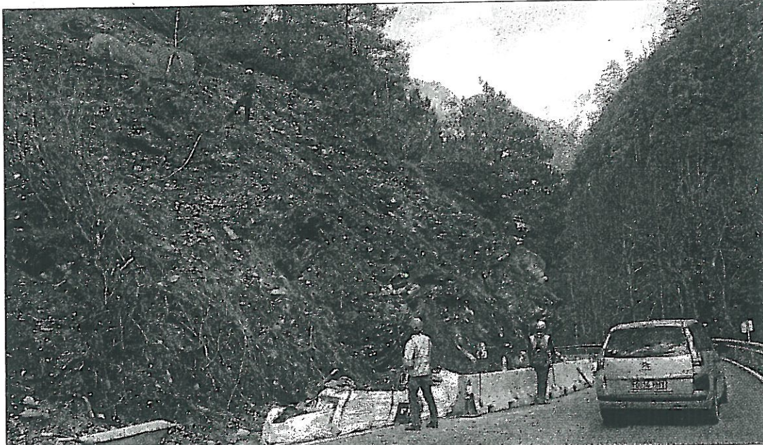
Els operaris treballaven ahir en la instal·lació de les malles metàl·liques.
