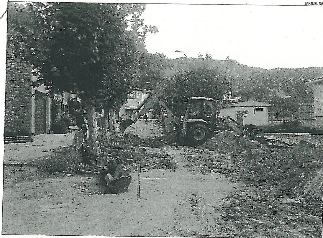
Les obres de l'avinguda Barcelona han començat fa uns dies.
