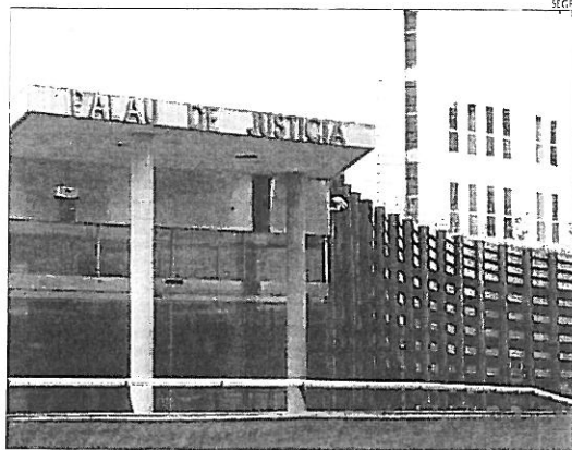
Imatge d'arxiu de l'edifici judicial del Canyeret.
