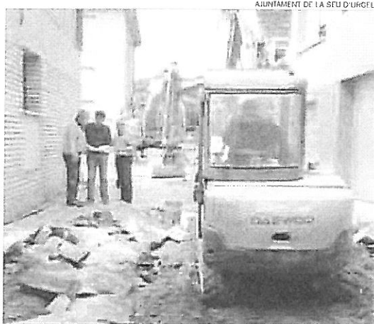
Els treballs de reurbanització de la zona de l'Urbanització Mallol.
