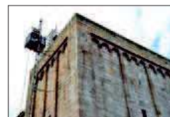
Inici de la intervenció.
