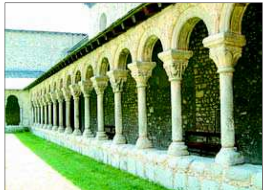
FOTO: / El projecte inclou la reforma del claustre de la catedral
