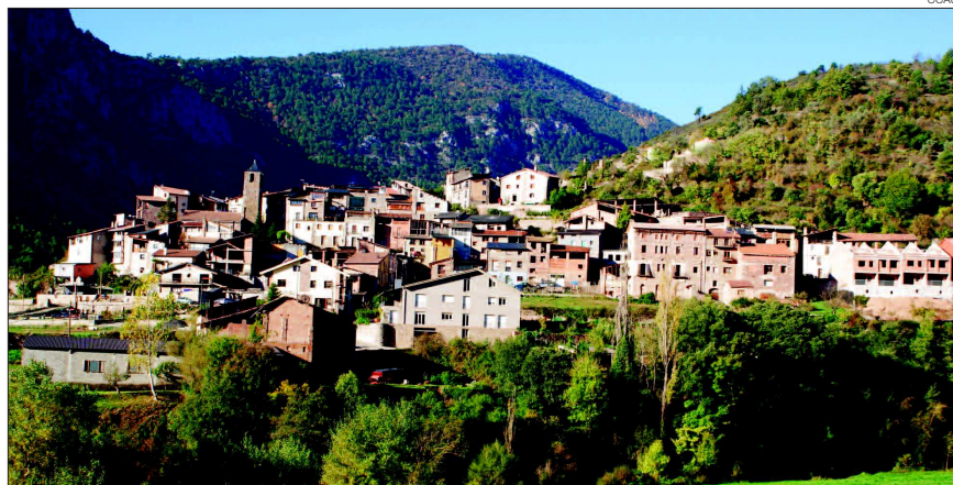
►► Vista panoràmica del poble Noves de Segre.
