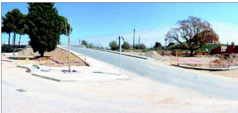
FOTO: Jordi Pascual / Imatge de les obres de l'entorn del centre escolar Antònia Simó d'Almacelles
