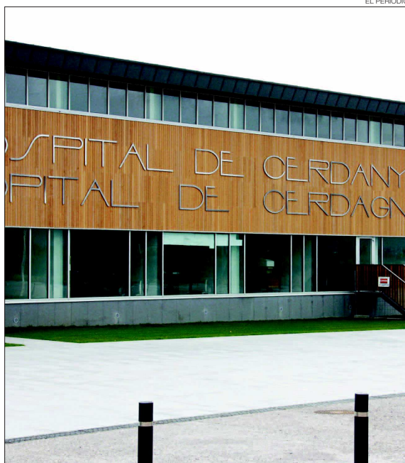
► Façana principal de l'Hospital de Cerdanya.
