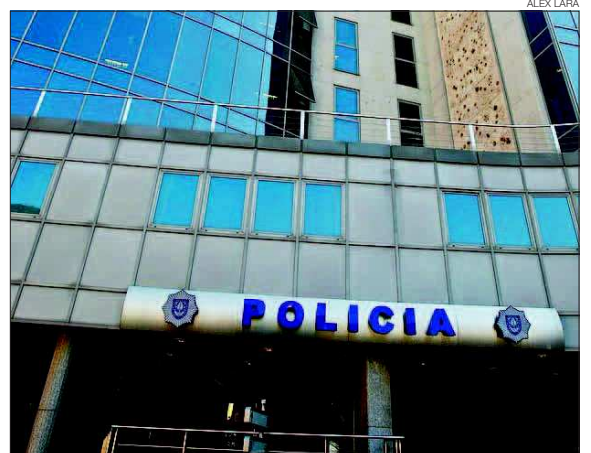
► Façana de l'edifici de la Policia.
