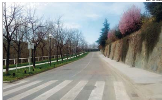
► La nova estrada del camí de la Palanca, després de la pavimentació.
