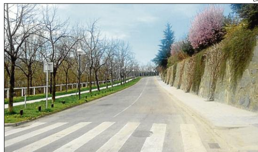
El camí de la Palanca de la Seu, que ha estat arreglat per l'Ajuntament
