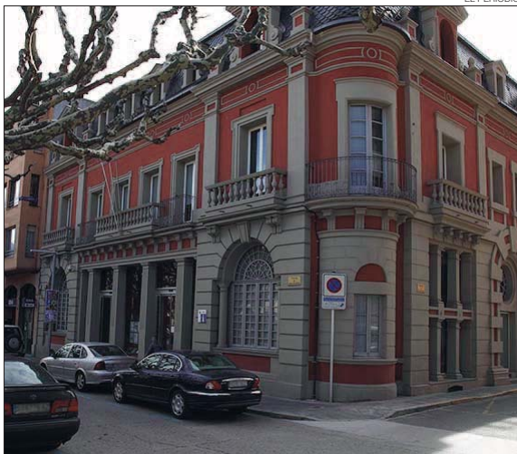
► Edifici administratiu del Consell Comarcal de l'Alt Urgell.
