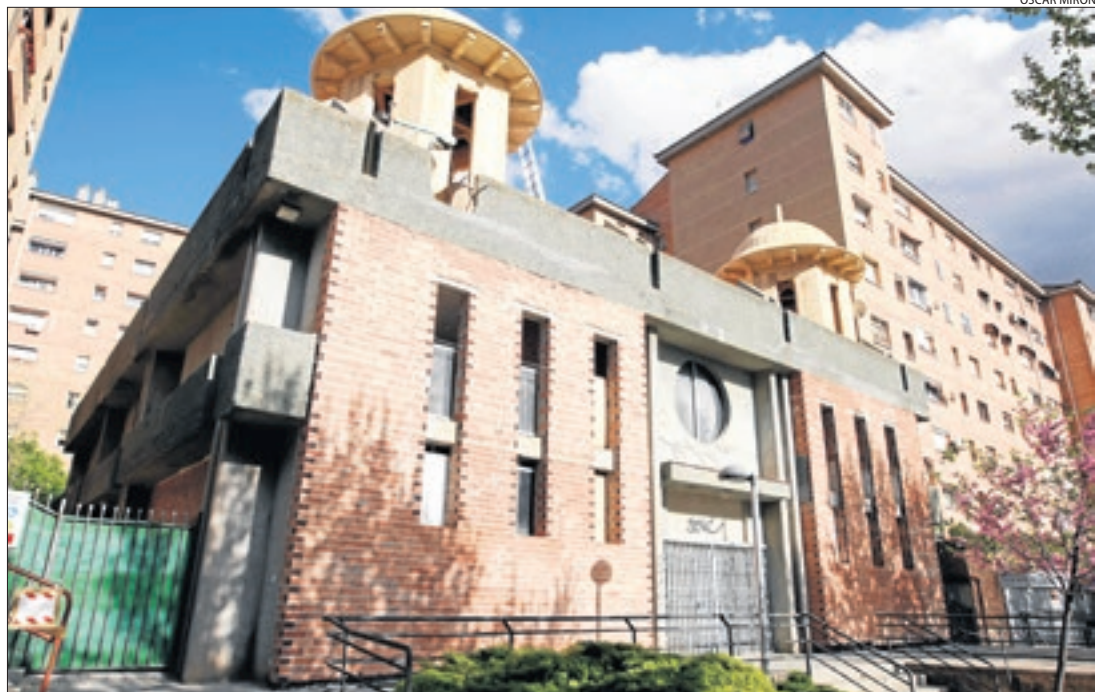
Les estructures de les dos torres ja estan instal·lades a la coberta de l'antiga comissaria de Ronda.
