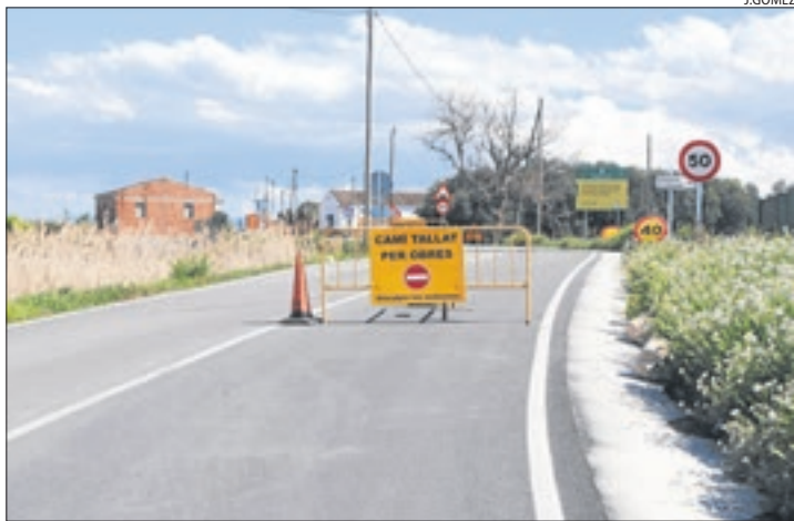
La carretera està actualment tancada al trànsit entre setmana.
