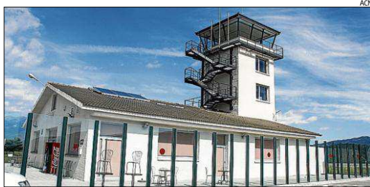
Torre de control de l'aeroport d'Andorra-la Seu
