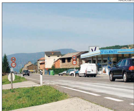
► El punt on es construirà la rotonda a la N-260.
