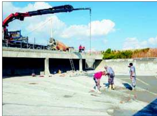
FOTO: Josep A. Pérez / Imatge de les obres de millora al dipòsit d'aigua
