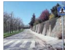
La vorera afectada per les obres.
