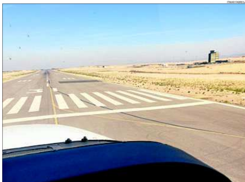
Vista des d'una avioneta de la pista de l'aeroport d'Alguaire, de 61 metres d'amplada.
