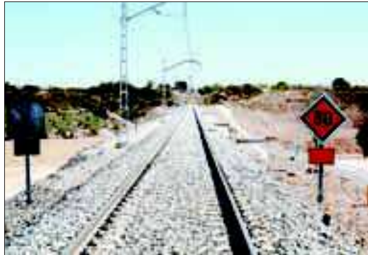
FOTO: O. Bosch (ACN) / Punt de l'R12 on s'ha realitzat les obres
