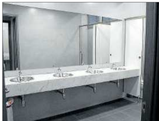
Aspecte renovat de l'espai de rentamans dels lavabos públics. LA SEU
