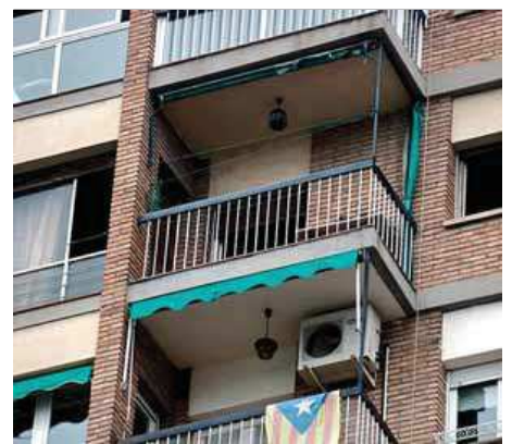
Incendi en un pis d'un edifici de l'avinguda de Madrid que va calcar una habitació i va provocar la mort d'una dona ■ ACN
