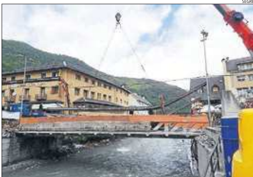
Treballs per desmantellar la passarel·la després de la riuada.
