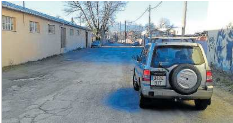
Un dels trams de l'antiga carretera de Barcelona, que serà remodelada l'any que ve. MIQUEL SPA
