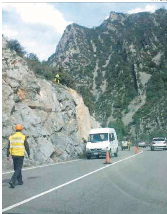
► Treballs a la carretera C-14 al tram de Trespunts.
