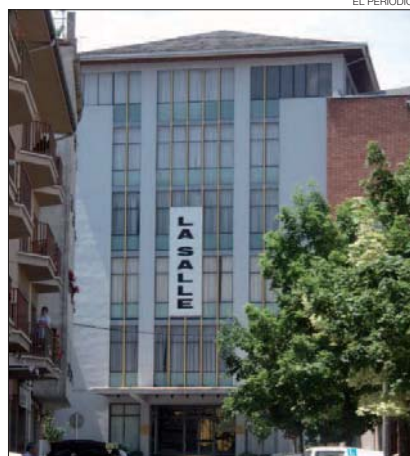
► Façana de l'edifici escolar, a la Seu.
