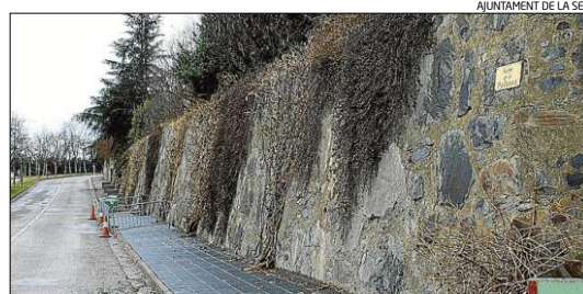
Les obres d'arranjament de la vorera nord del camí de la Palanca
