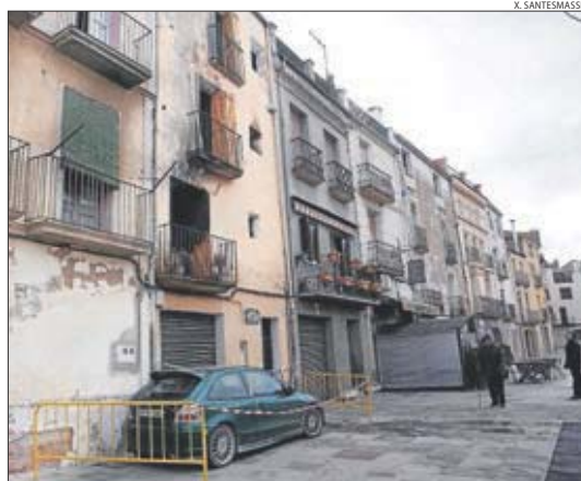
El foc va calcinar la primera planta i va afectar les altres dos.
