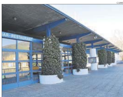
Les instal·lacions del bar restaurant del Parc del Segre.
