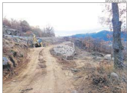
Les obres a la carretera LV-4036 a Lles de Cerdanya.
