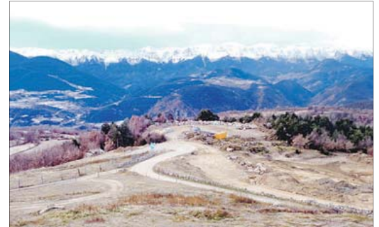
Les obres de millora de la carretera LV-4036.
