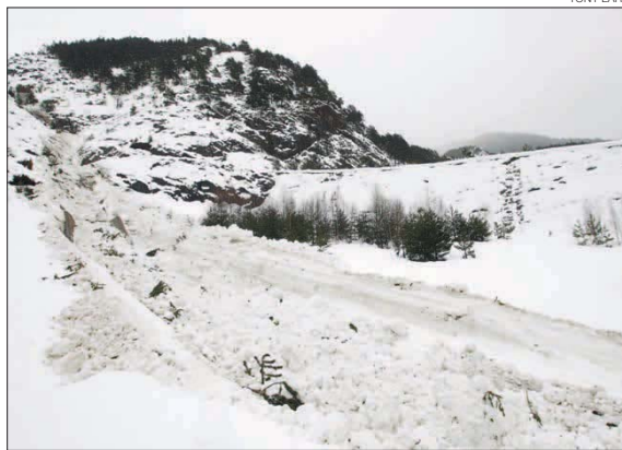
► Allau controlada al mur de contenció d'Arinsal.
