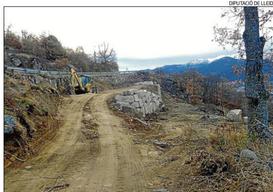
Una excavadora treballa en l'eixamplament de la carretera
