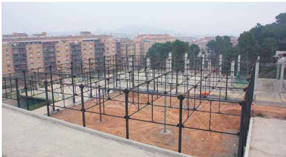
Obres de construcció del museu de la ciència, en els terrenys que són objecte del litigi ■ ACN
