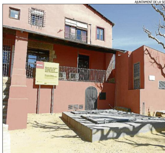
Zona de l'edifici de l'Ajuntament on s'ha instal·lat la nova caldera
