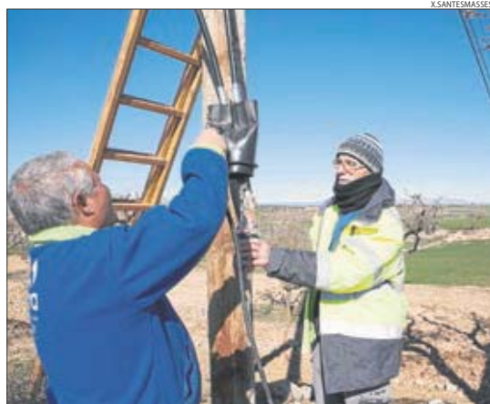
Operaris reparen el cable tallat, dilluns passat a Torrefeta.
