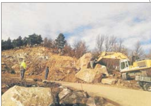
Imatges dels treballs que s'estan duent a terme.
